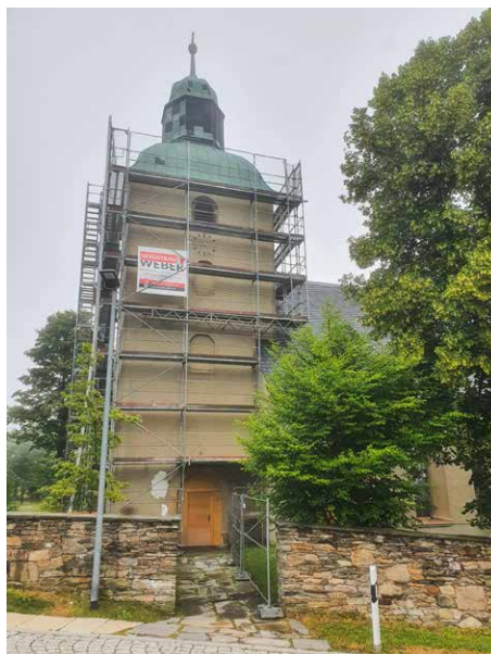
Baustelle Kirchturm Satzung
